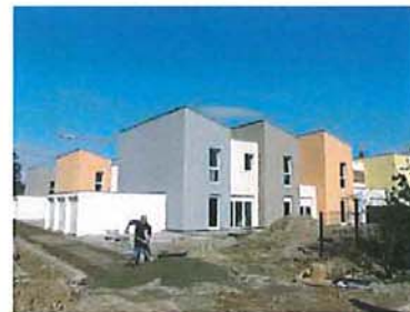
Logements sociaux en construction, Mulhouse
