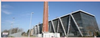
Centrale thermique de l'illberg
