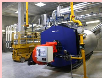
Centrale thermique de Rixheim
