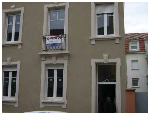
7 rue Zierdt à Mulhouse (à gauche: avant travaux, à droite après travaux réalisés par Néolia dans le cadre d'IGLOO)
