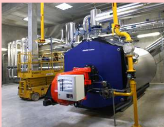
Centrale thermique de Rixheim
