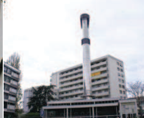
Chaufferie « Porte de Bâle »
