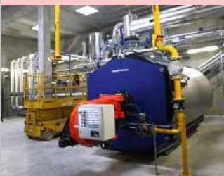
Centrale thermique de Rixheim
