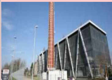
Centrale thermique de l'illberg
