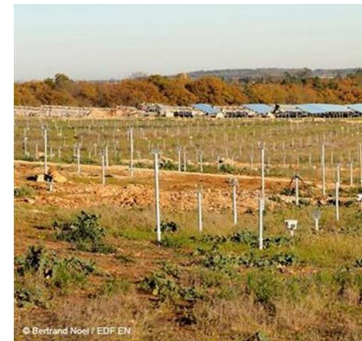
Photographie 4 : Fondation pieux battus
