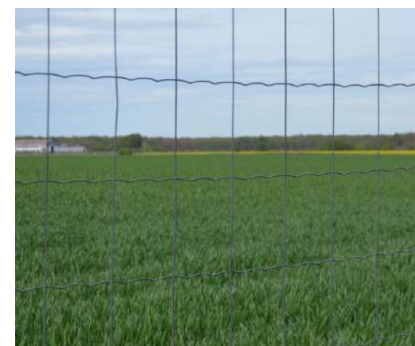
Figure 172 : Clôture existante à mailles permettant le transit de la petite faune
