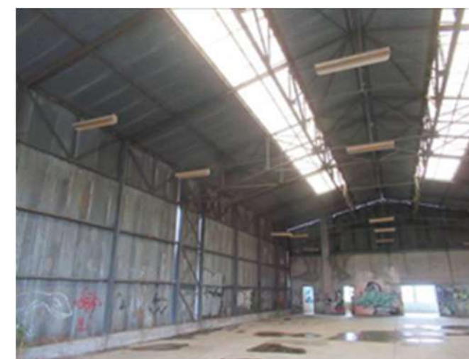
Figure 93 : Aperçu des hangars et bâtiments désaffectés (OTE, 2018)
