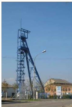
Chevalement Théodore et exemple de bardage métallique pour les locaux techniques
