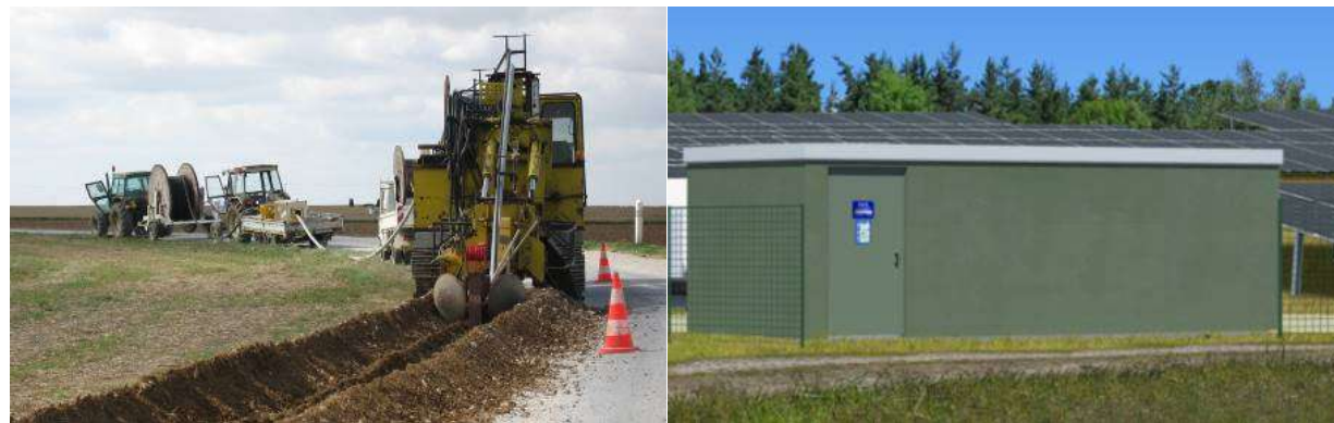
Photographie 6 : Déroulage et pose des câbles (à gauche), exemple de poste de livraison (à droite)
