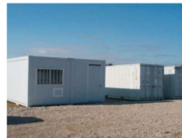
Photographie 2 : Installation de la base-vie Source : EDF Renouvelables France
