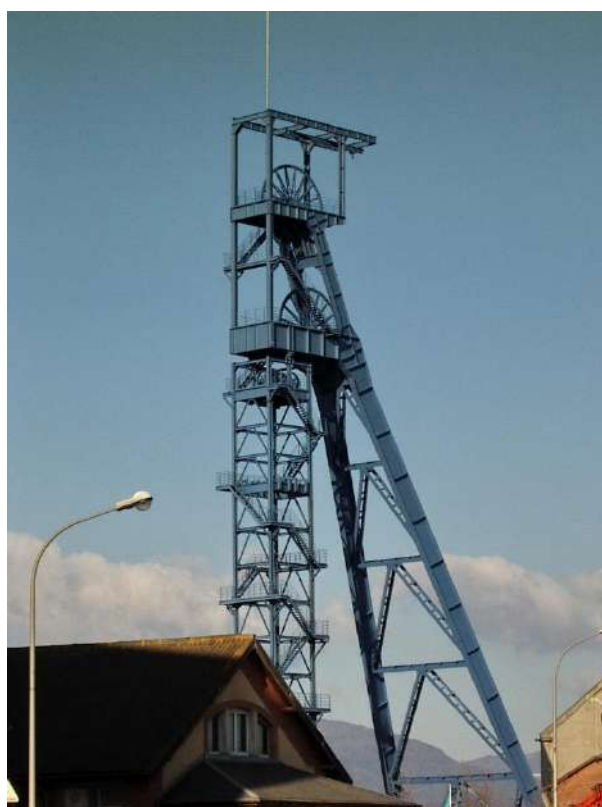
Illustration 47 : Chevalement du puits de mine (carreau Théodore)
