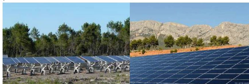
Photographie 1 : Structures solaires (à gauche: les trackers de la centrale de Gabardan (40) qui suivent le soleil ; à droite : structures fixes à Puylobier (13)) - Source : EDF RENOUELABLES
