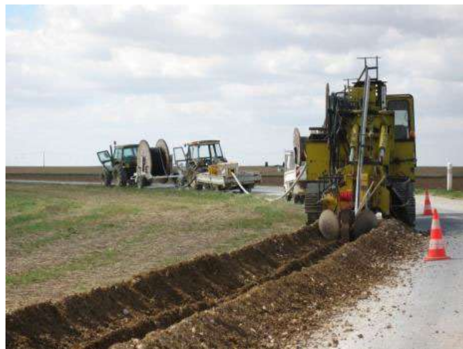
Figure 167 : Illustration des travaux de raccordement réalisés par ENEDIS (source : EDF Renouvelables)
