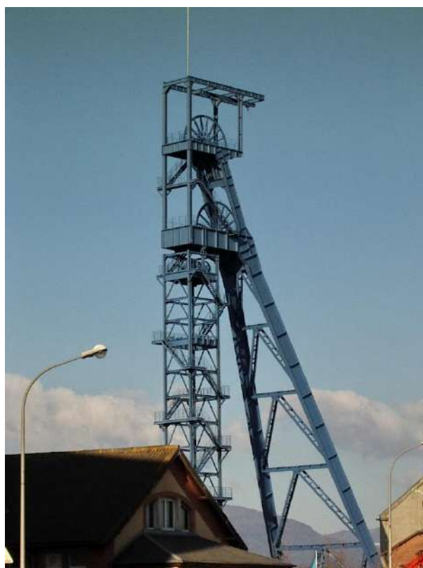
Illustration 47 : Chevalement du puits de mine (carreau Théodore)
