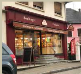
Dispositif d'enseigne au-dessus de vitrine et d'oriflamme sans ancrage au sol
