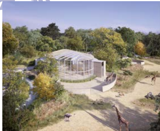
En 2021, les travaux de l'Horizon Afrique sont lancés
