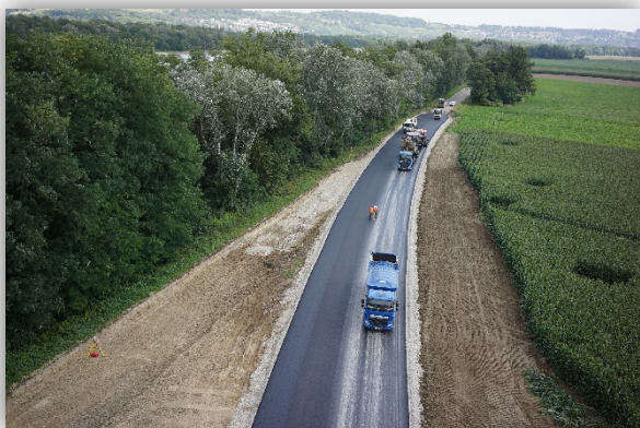
Réalisation d'un nouveau tracé 1,4 km de nouvelle voie départementale
