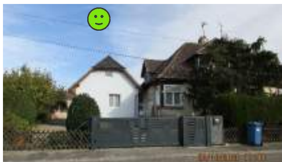
Volume de l'extension détaché de celui de la maison d'origine. Un élément de liaison à toit plat de faible surface fait le lien entre la maison existante et l'extension. (source : UDAP, cité minière Sainte-Barbe à Wittenheim)
