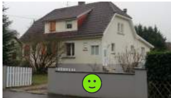
Mur maçonné enduit
