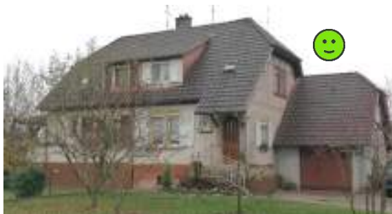
Extension en recul : toiture et matériaux en harmonie avec la maison d'origine, sans masquer les pans de bois en pignon.
