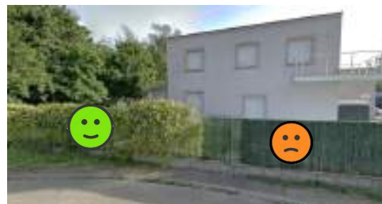
Haie de plantes grimpantes à fleurs intérieure à un grillage en limite de voie : agrément paysager et biodiversité contrastant avec le reste du linéaire traité en haie artificielle synthétique déroulée sur le grillage
