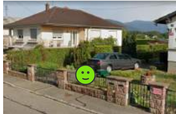
Clôture sur rue de type grille métallique sur mur bahut
