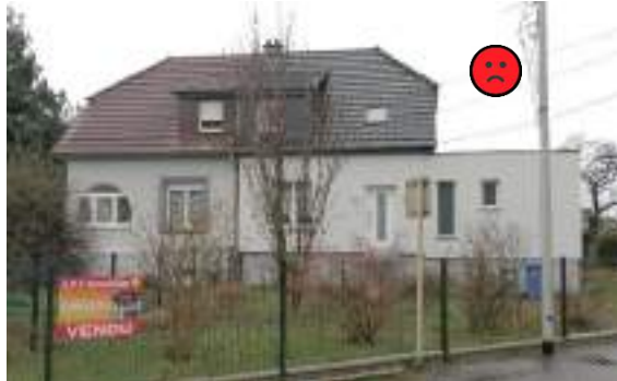
Extension doublant et étirant la façade, toiture plate. Contraste mal joué entre maison d'origine et extension.
