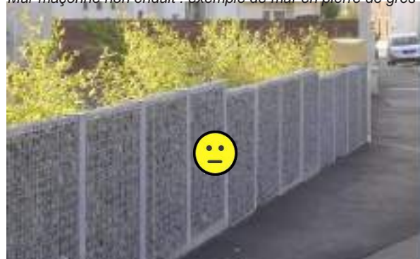
Mur de pierre en gabion : une version revisitée du mur de pierre avec une esthétique et un rendu plus contemporains
