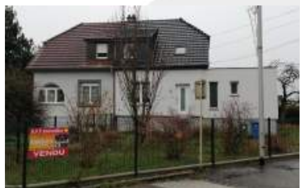
Exemple de perte de l'identité : extension à toiture plate, doublant et étirant la maison initiale en façade et en volume, sans décrochement marquant la façade d'origine.
