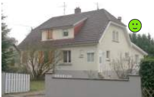
Extension réalisée à l'arrière, harmonie des lignes et matériaux, toiture monopan à hauteur de l'égout du toit.
