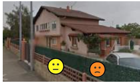
Clôture à claire-voie en ciment sur mur-bahut mais doublée par un grillage occulté par une haie artificielle
