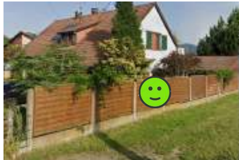
Clôture sur limite séparative de type claustra en bois doublée d'une haie contrebalançant la monotonie.
