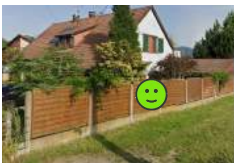
Clôture sur limite séparative de type claustra en bois doublée d'une haie contrebalançant la monotonie.
