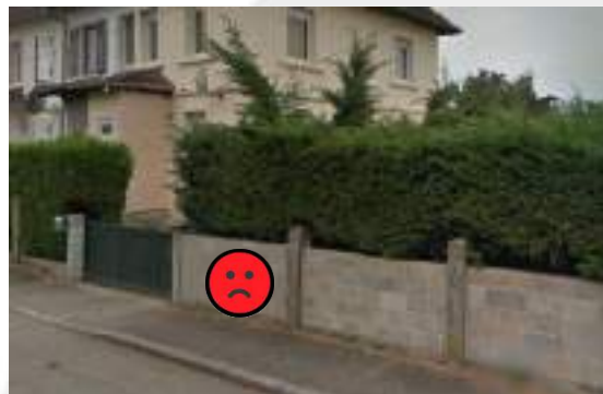
Mur en aggloméré non enduit (double d'une haie intérieure) : l'esthétique, la qualité et l'intégration ne sont pas satisfaisantes
