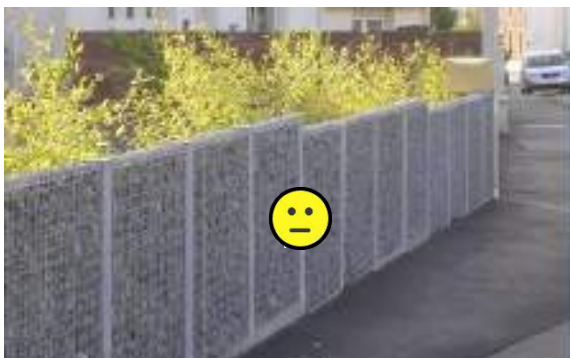
Mur de pierre en gabion : une version revisitée du mur de pierre avec une esthétique et un rendu plus contemporains
