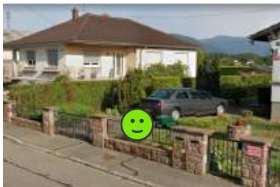
Clôture sur rue de type grille métallique sur mur bahut
