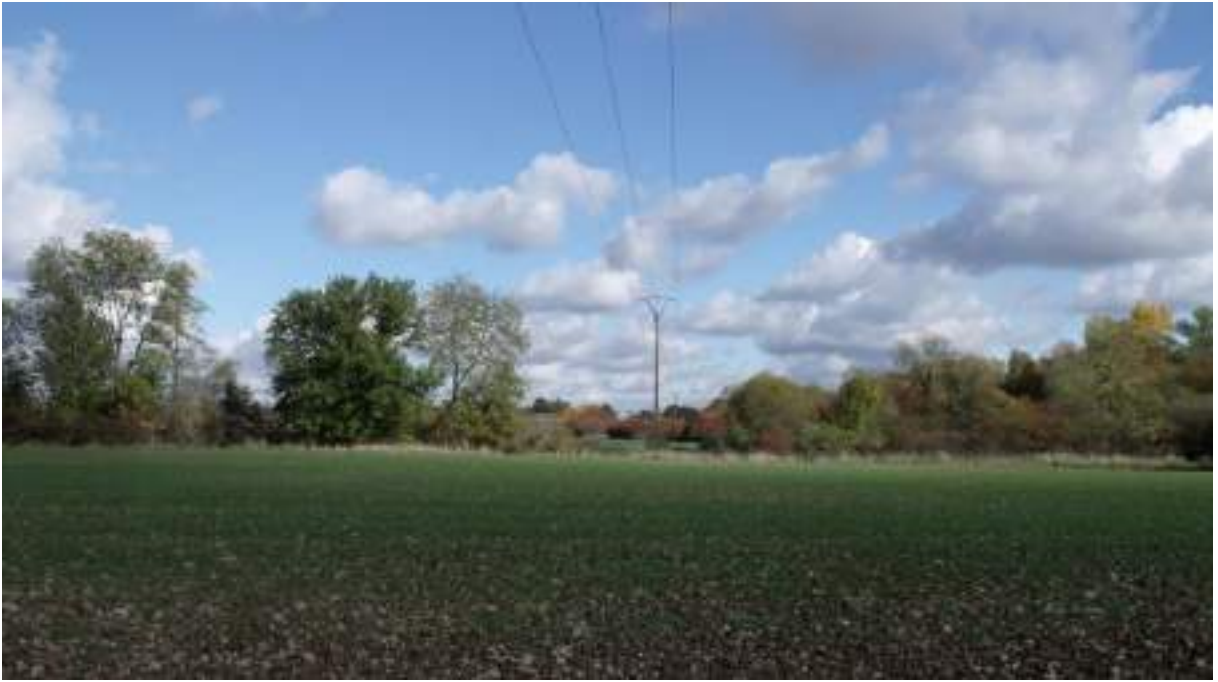
Fig.58 Vue n°4 : Ligne électrique et pylônes bien visible dans le paysage agricole
