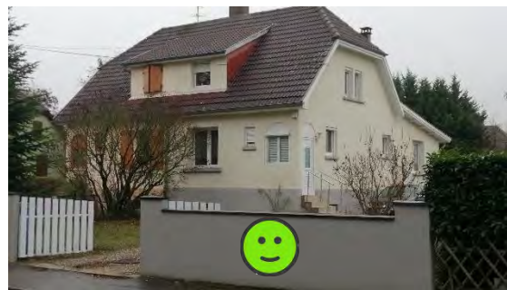
Mur maçonné enduit
