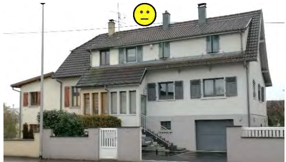
Extension de taille raisonnable avec harmonie de traitement. Toutefois, un léger décrochement en façade à compter du garage et/ou une longueur de lucarne raccourcie pour permettre une toiture en croupe auraient mieux mis en avant le volume d'origine.
