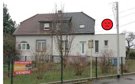
Extension doublant et étirant la façade, toiture plate.
