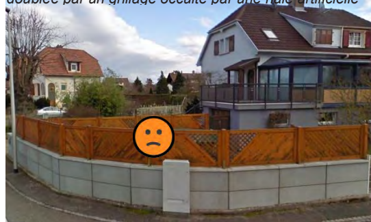
Clôture sur rue de type claustra en bois ne permettant pas ou peu de lien visuel entre l'espace privé et public.
