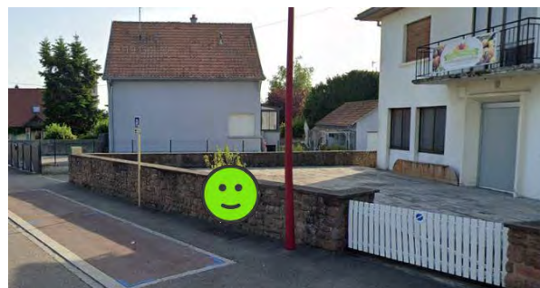
Mur maçonné non enduit : exemple de mur en pierre de grès
