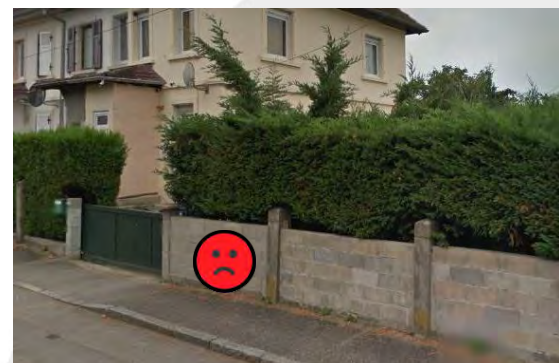
Mur en aggloméré non enduit (double d'une haie intérieure) : l'esthétique, la qualité et l'intégration ne sont pas satisfaisantes
