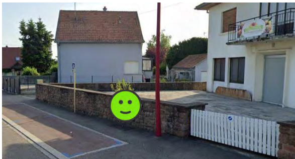
Mur maçonné non enduit : exemple de mur en pierre de grès
