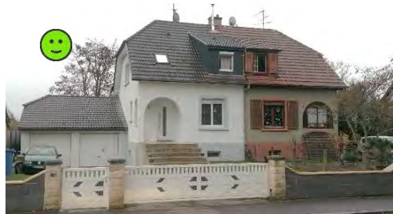
Extension en recul de la façade avec toiture 2 pans à croupe. Couverture et revêtement en harmonie
