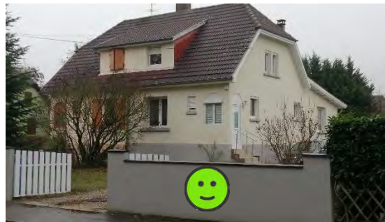
Mur maçonné enduit
