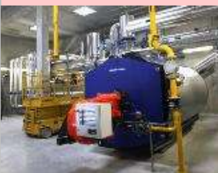
Centrale thermique de Rixheim
