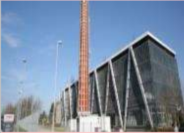
Centrale thermique de l'Illberg
