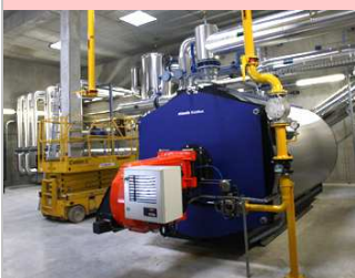
Centrale thermique de Rixheim
