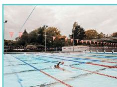
6 LE CENTRE D'ENTRAÎNEMENT ET DE FORMATION À LA NATATION DE HAUT NIVEAU Boulevard Charles Stœssel
