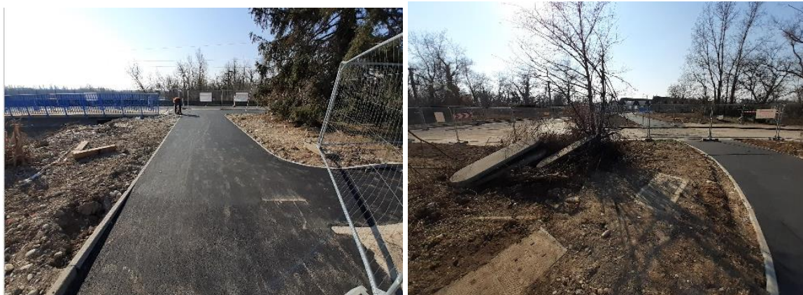
Aménagements de voirie et espaces verts
