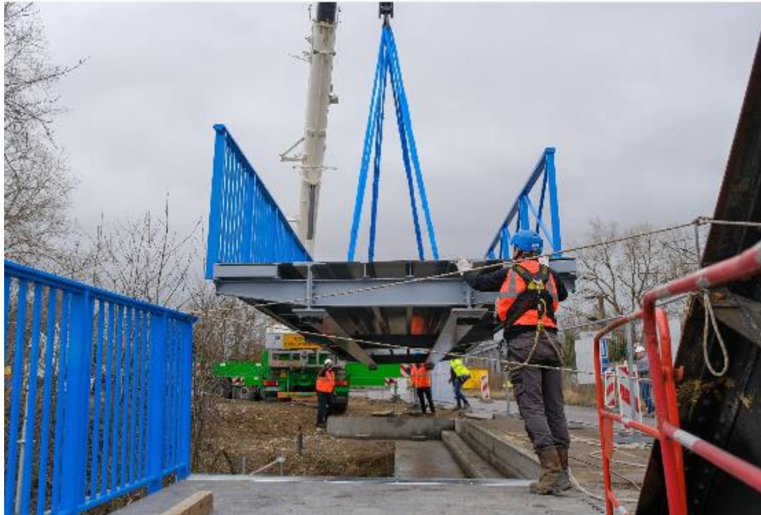
Pose d'une passerelle de 11m de long et 3 m de large
