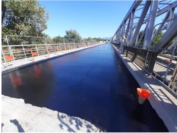
Mise en œuvre du complexe d'étanchéité.
