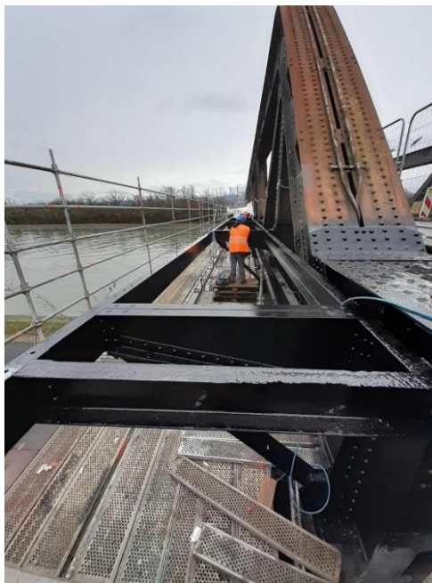
Pose des consoles sur lesquelles sont basées les plateaux.
