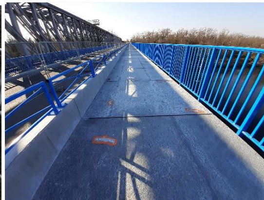
Pose d'une centaine de dalles préfabriquées en BFUP.
