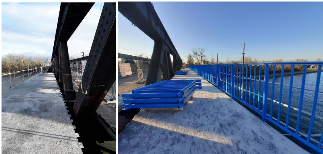
Installation des plateaux métalliques piétons/cyclistes.
