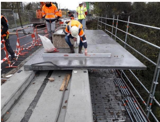
Pose d'une centaine de dalles préfabriquées en BFUP.
