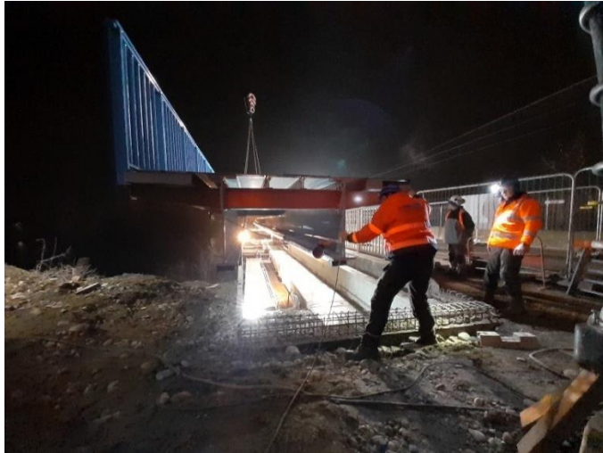
Pose d'une première passerelle piétons/cyclistes fin janvier.
