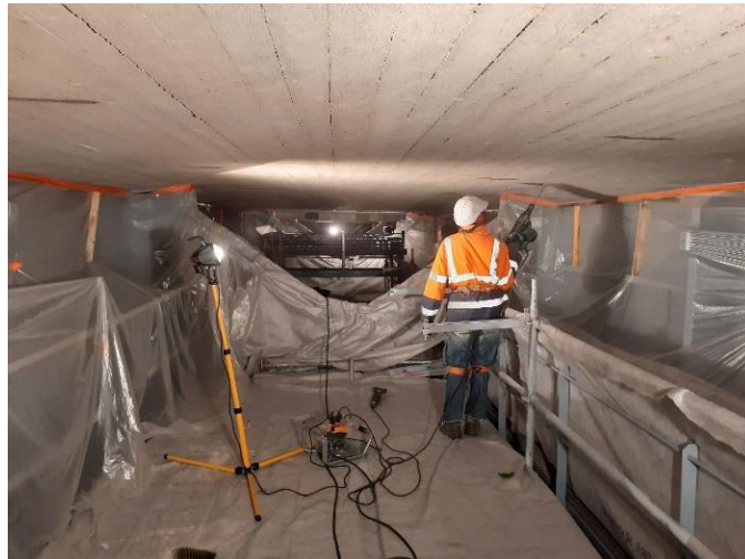
Réparation des bétons dégradés.
