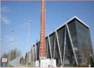
Centrale thermique de l'Illberg
