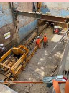
Travaux sur le réseaux dans le quartier Bel Air
