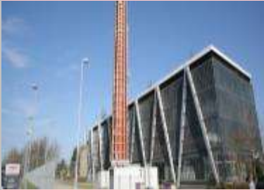
Centrale thermique de l'Illberg
