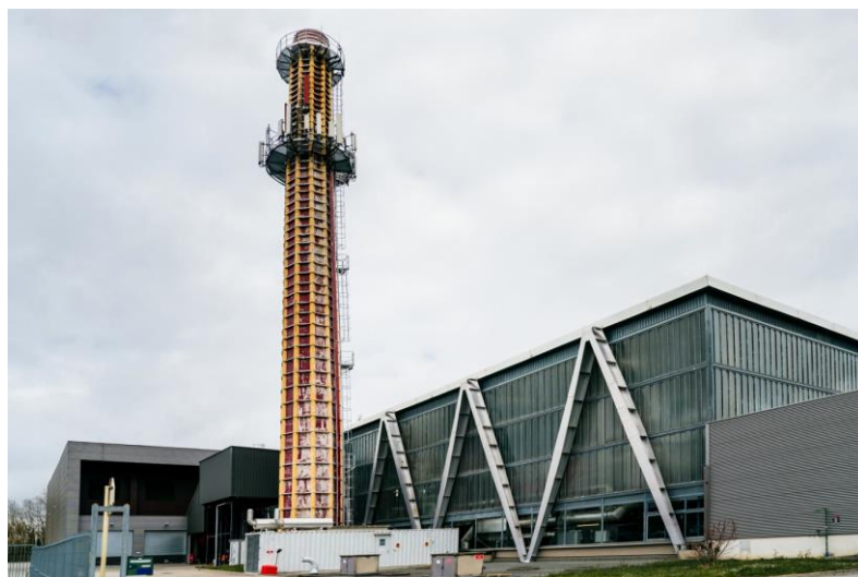
Centrale Thermique de l'Illberg à Brunstatt-Didenheim
