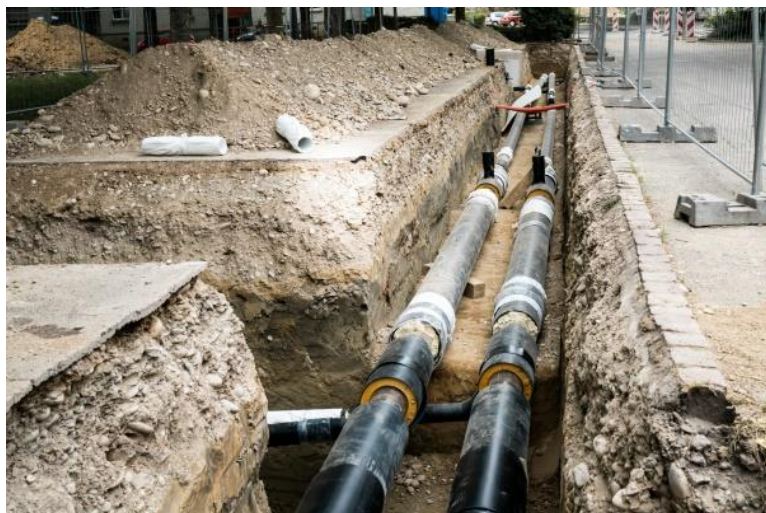
Intégrations des tuyaux de réseaux de chaleur au quartier Bel-Air
