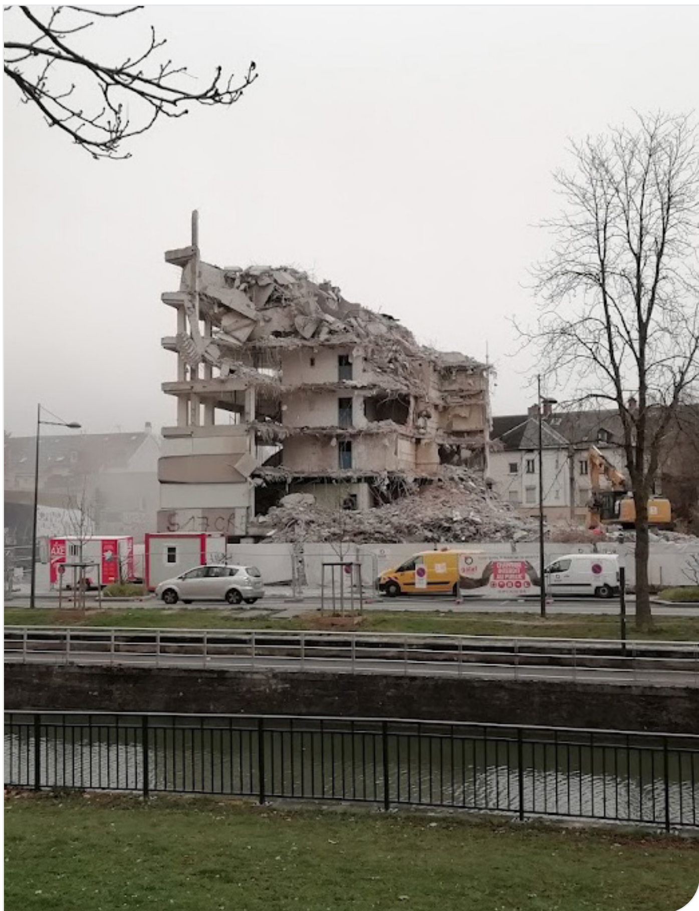
Démolition du foyer les Marronniers, Mulhouse 2022
