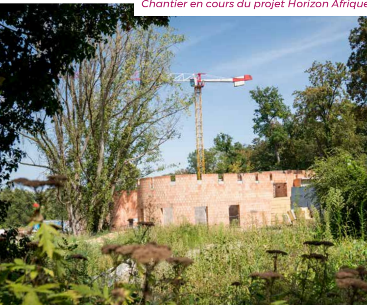
Chantier en cours du projet Horizon Afrique
