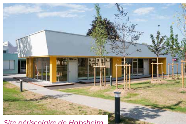
Site périscolaire de Habsheim
