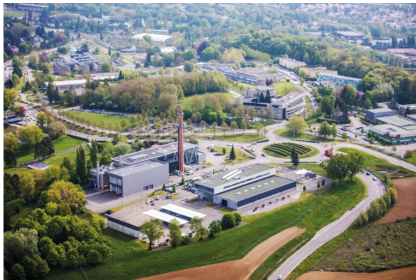
Centrale thermique de l'Illberg
