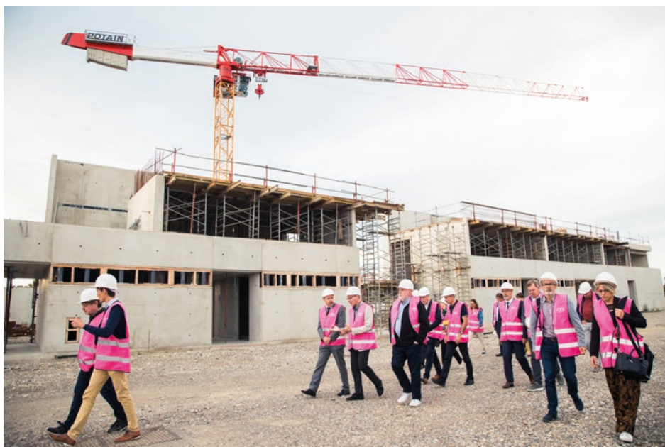
Visite du chantier de la nouvelle halle du Parc Expo m2A (2023).
