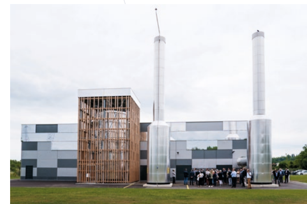
Centrale thermique de Rixheim
