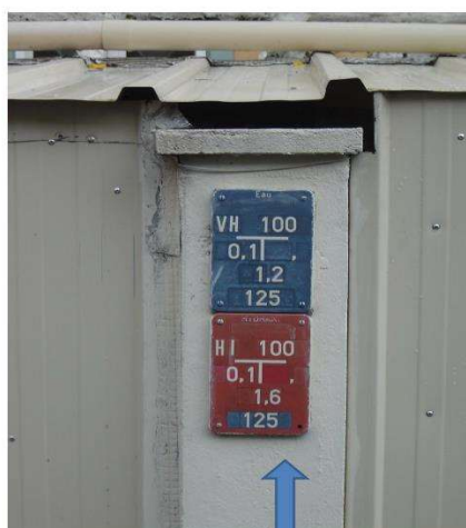
Hydrant de 100mm ou bouche d'incendie avec R.V.
