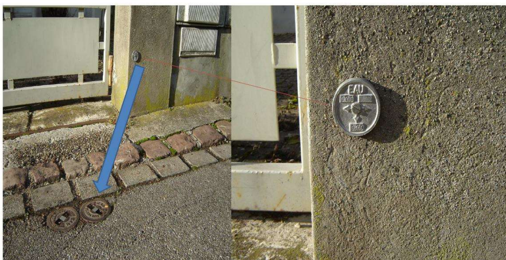
DECALAGE ENTRE LA B.A.C. ET LA PLAQUETTE POUR BRANCHEMENT – DE 60mm
