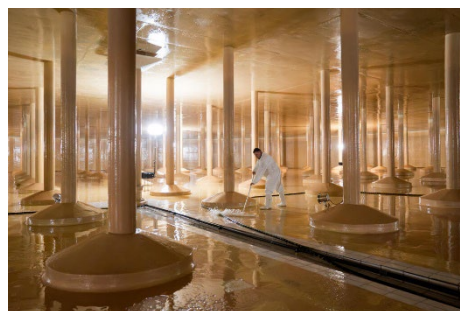
Nettoyage du réservoir de l'Illberg.
