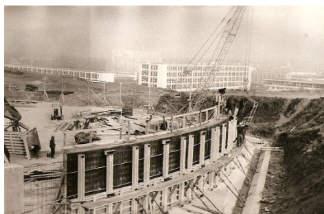
Construction du réservoir de l'Illberg.
