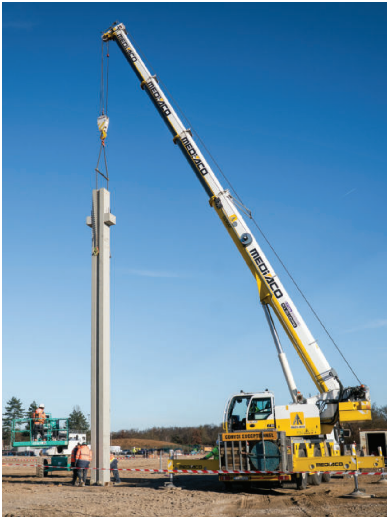
▼ Pose des premiers poteaux du bâtiment du groupe VGP à Sausheim.
