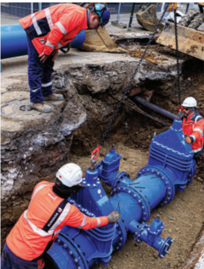
Installation d'une batterie de vanne dans le cadre du chantier de renouvellement de la canalisation d'eau Avenue Aristide Briand à Mulhouse.
