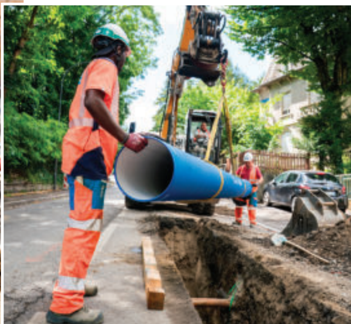
▲ Chantier de la Régie de l'Eau m2A à Mulhouse.
