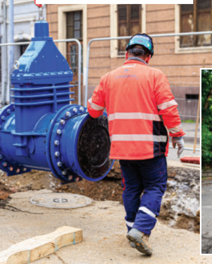
Installation d'une batterie de vanne dans le cadre du chantier de renouvellement de la canalisation d'eau Avenue Aristide Briand à Mulhouse.
