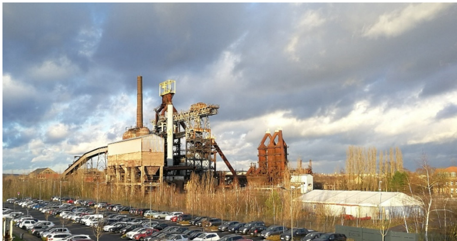
Photo n° 2 : parc du haut-fourneau U4 à Uckange (57)
