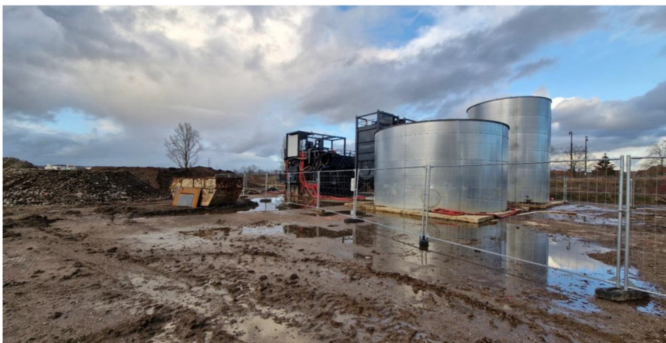
Photo n° 1 : ZAC Rive gauche à Thionville - usine mobile de lavage des terres polluées 7
